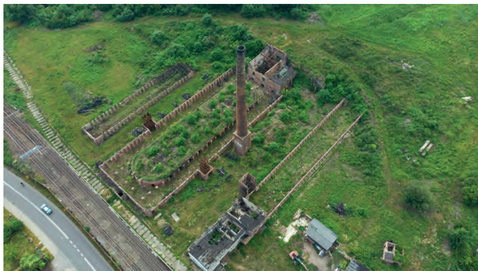
Ryc. 13. Widok na cegielnię „Zgoda”, dawniej należącej do rodziny Lindke. Fot. K. Rychel Fig. 13. “Zgoda” brickyard, formerly owned by the Lindke family. Photograph by K. Rychel
