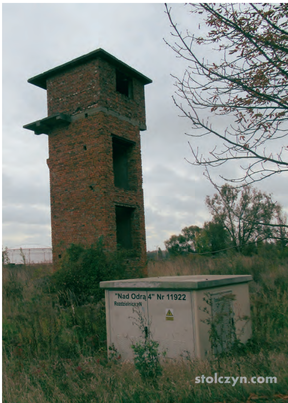
Ryc. 7. Szyb windy cegielni Feldmühle , ul. Nad Odrą. Fot. P. Romanowicz Fig. 7. Feldmühle brickyard lift shaft, Nad Odrą Street. Photograph by P. Romanowicz
