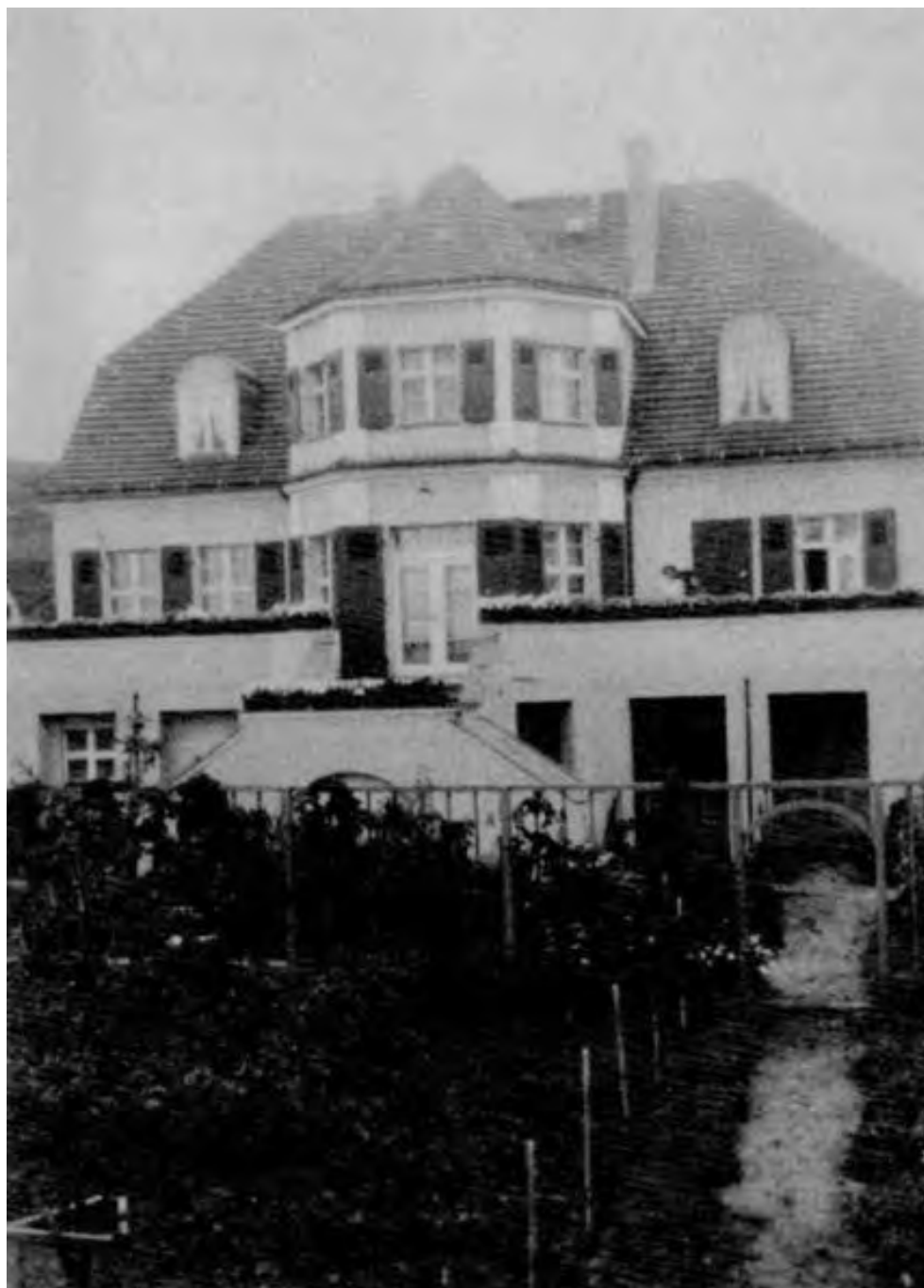
Ryc. 11. Willa rodziny Lindke z 1926 r. przy ul. Nad Odrą 6. Źródło: K. Dummann 1986 Fig. 11. House of the Lindke family in 6 Nad Odrą Street in 1926. Source: K. Dummann 1986
